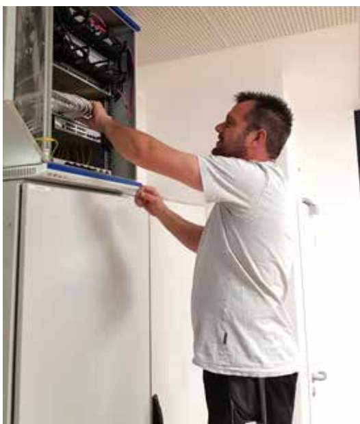
Holger Schwarz installierte das Netzwerk an der GMS Jettingen.
